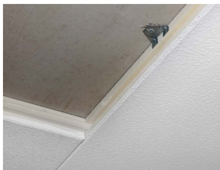
Kellerdeckendämmung unter Betondecke
