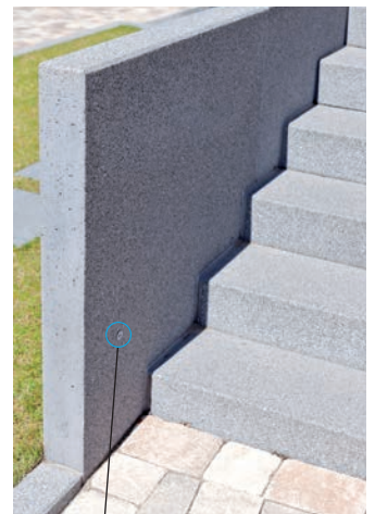
Ankerhülsen verschlossen mit grauen Kunststoffkappen
