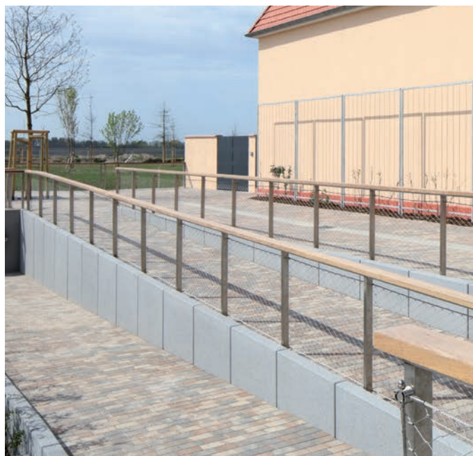
F-Roppenheim (67), „The Style Outlets“
