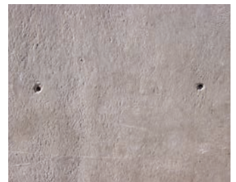
Ankerhülsen als Versetzhilfe
