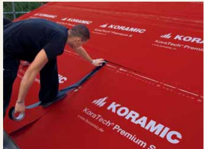
Das KoraTech®-Systemzubehör umfasst das Universalklebeband Multi Tape und den Anschlusskleber Multi Fix sowie die passenden Nageldichtmaterialien Nail Tape Butyl, Nail Tape Foam und Nail Fluid. Sie bieten zusammen mit den Unterdeckbahnen bestmöglichen Schutz vor Regeneintrag in die Unterkonstruktion.
