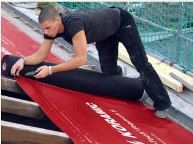
Die Unterdeckbahn wird parallel zur Traufe zeigend ausgerollt, abgelängt, ausgerichtet und fixiert.
